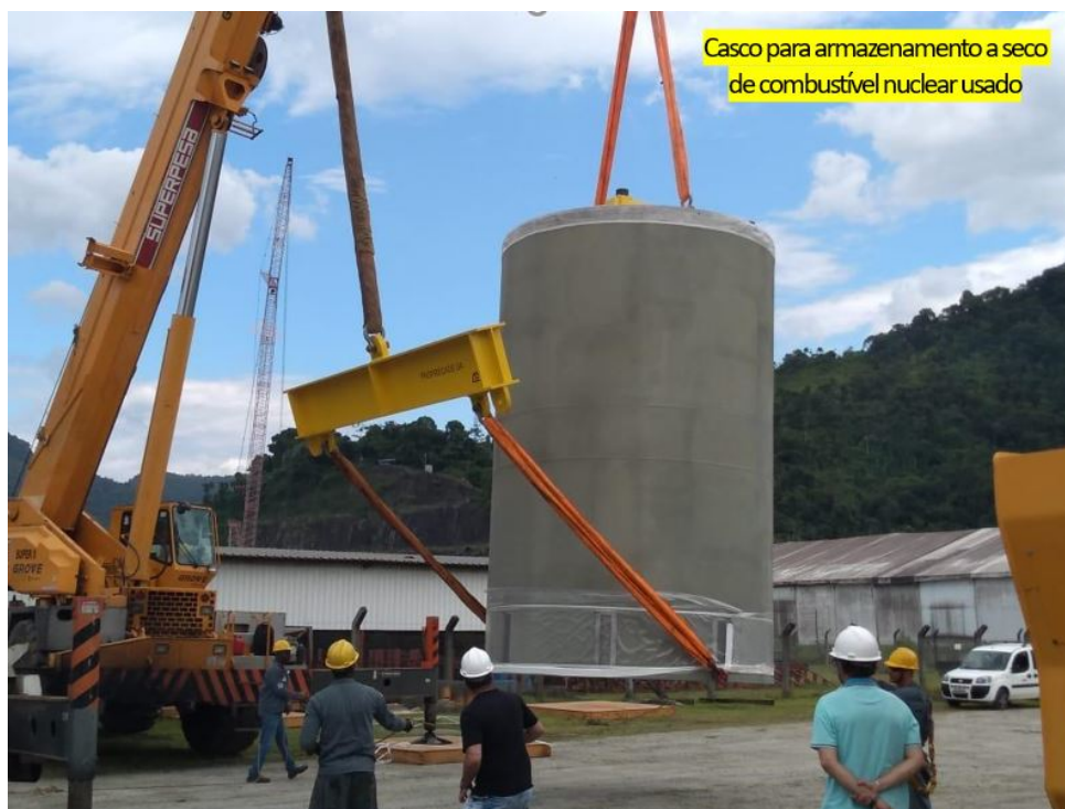
Figura 1.1: Exemplo de casco para armazenamento a seco de combustível nuclear usado. Fonte: http://www.eletronuclear.gov.br/Imprensa-e-Midias/Paginas/Eletronuclear-recebe-módulos-de-armazenamento-da-UAS.aspx .
