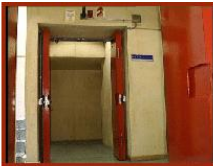
Fig. 4.3 – Porta de acesso à sala de irradiação.
