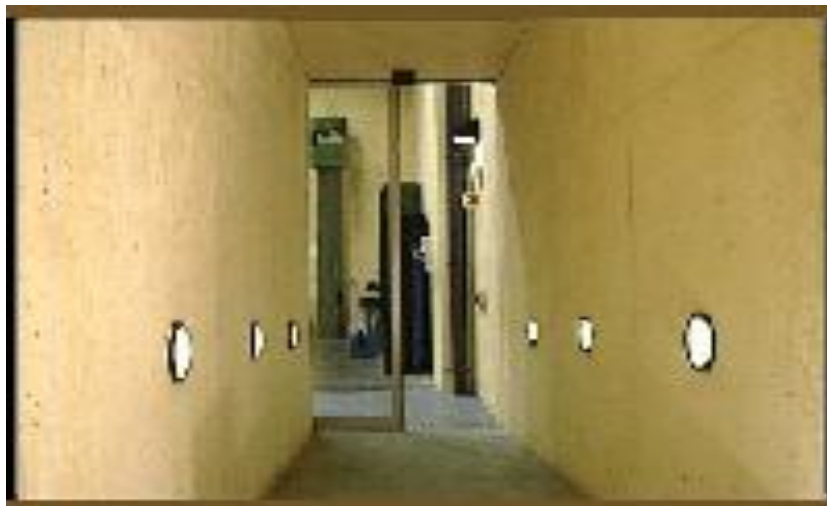
Fig. 4.2 – Corredor de acesso à sala de irradiação.
