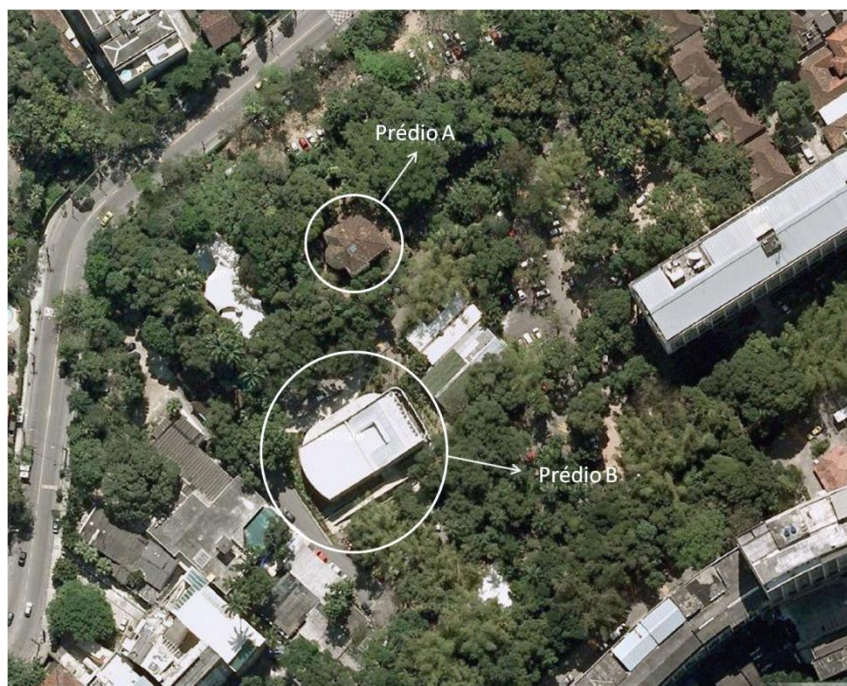
Figura 3.1 - Foto aérea do bairro da Gávea com a localização dos Prédios A e B
