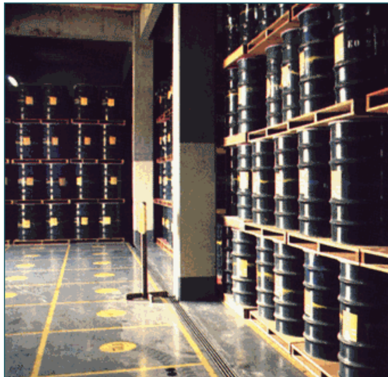
Figura III.2. Visão geral do armazenamento de rejeitos radioativos dentro do depósito da Usina Nuclear Angra I.
