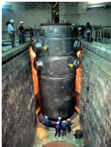
Figura 1.2: Reator do tipo PWR sendo instalado [2].
