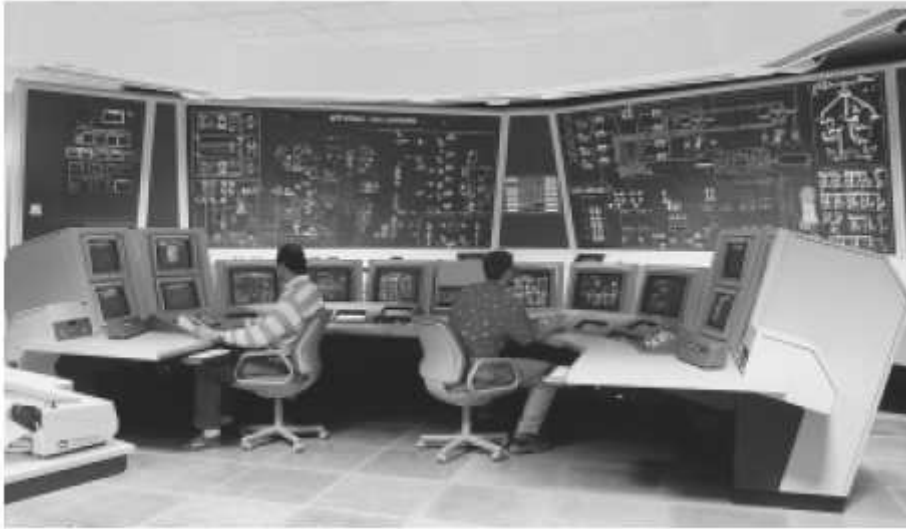
Figura 1.2 - Sala de Controle Digital (IAEA, 1999)
