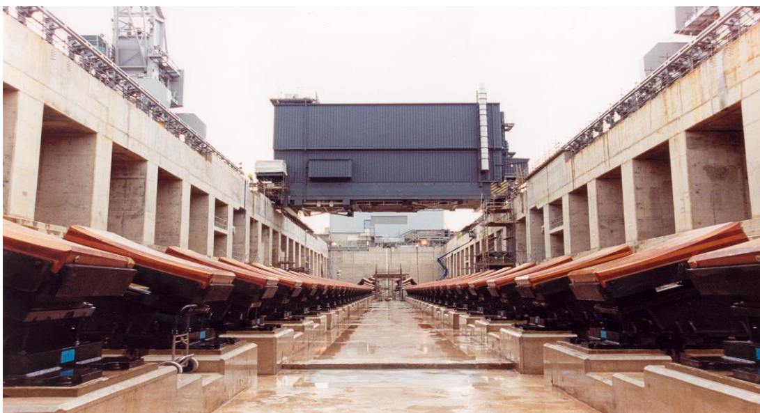
Figura 4.2 - Dique de HMNB Plymouth, Inglaterra
