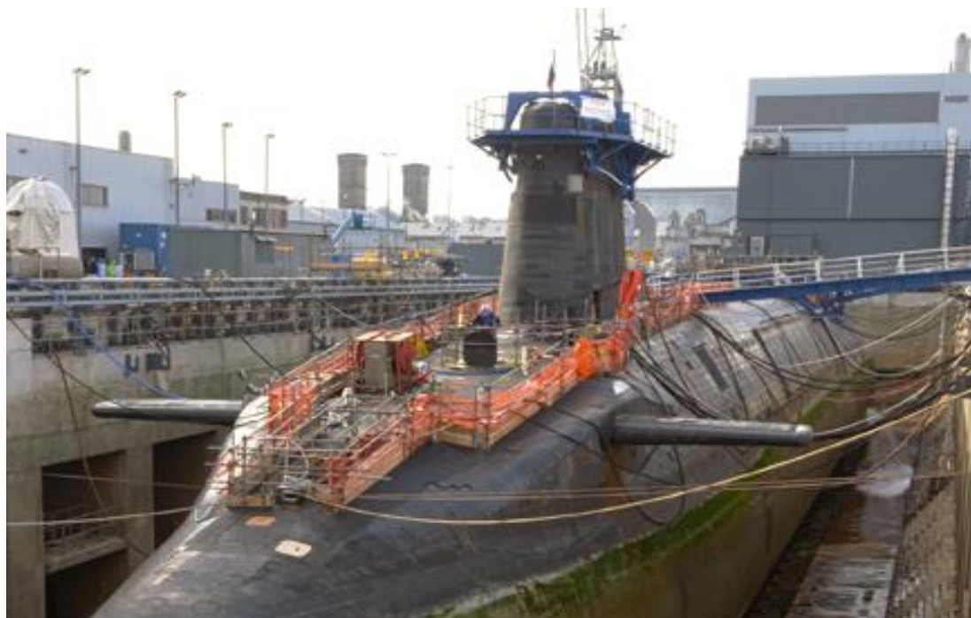
Figura 4.3 - Grua de Acesso de um submarino inglês em processo de descomissionamento
