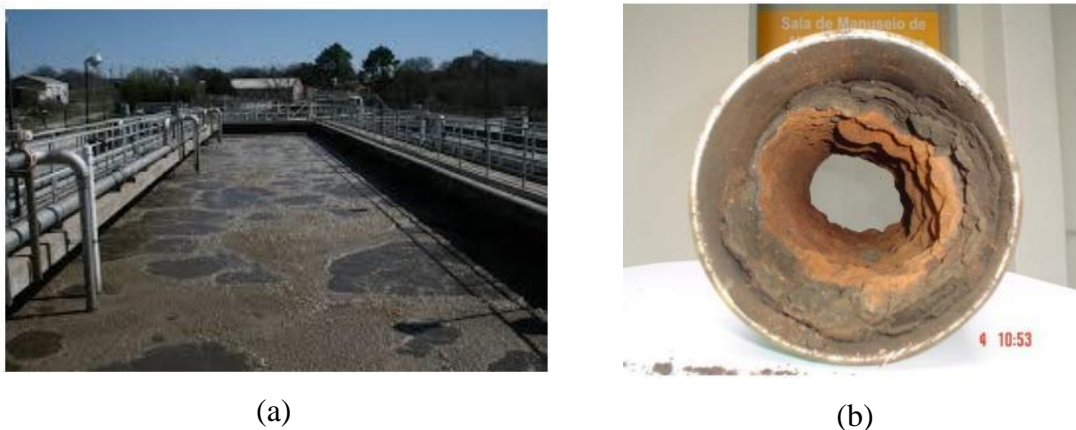
Figura 3.3 - (a) borras radioativas; (b) incrustação nos tubos (GAZINEU et al. , 2005b).
