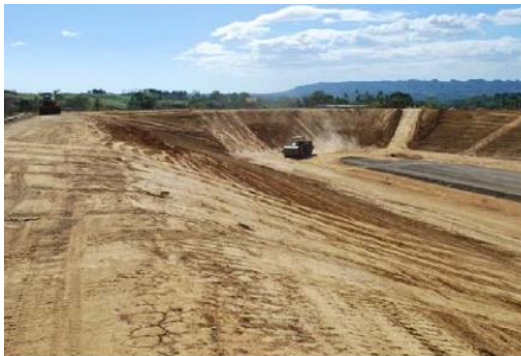
Figura 5.22 - Compactação dos rejeitos colocados no aterro para o nivelamento das camadas e na área total (PAUL, 2011).
