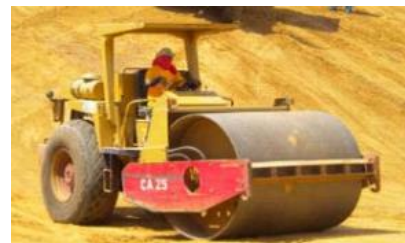
Figura 5.22 - Compactação dos rejeitos colocados no aterro para o nivelamento das camadas e na área total (PAUL, 2011).
